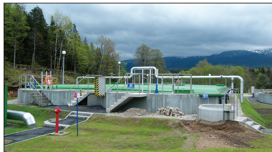
Nowo wybudowana oczyszczalnia ścieków przy ul. Hofmana w Szklarskiej Porębie
