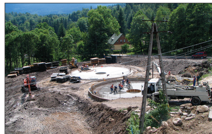
Szklarska Poręba – budowa oczyszczalni ścieków
