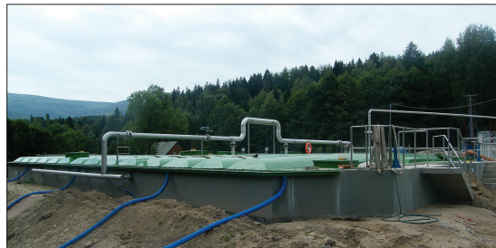
Oczyszczalnia ścieków w Szklarskiej Porębie.
