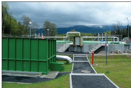
Oczyszczalnia ścieków w Szklarskiej Porębie przy ul. Hofmana wybudowana w ramach Kontraktu Nr X.
