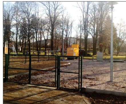
Przepompownia ścieków w Mysłakowicach
