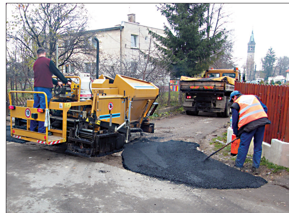
Miłków – odtwarzanie nawierzchni dróg
